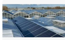
solargreenhousesystems.nl Zonne-energie voor de tuinbouw | Solar ...
