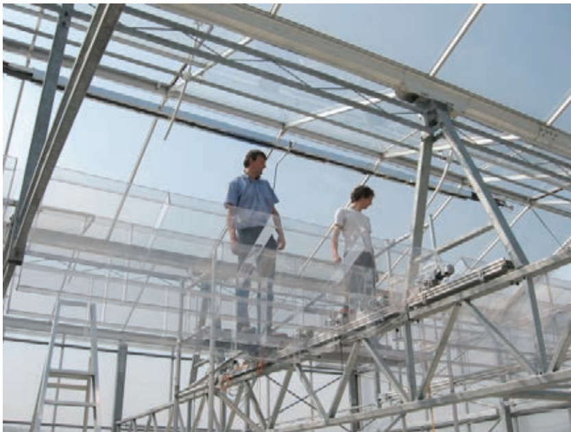
Figuur 39. Montage van de lamellen in de proefkas.
