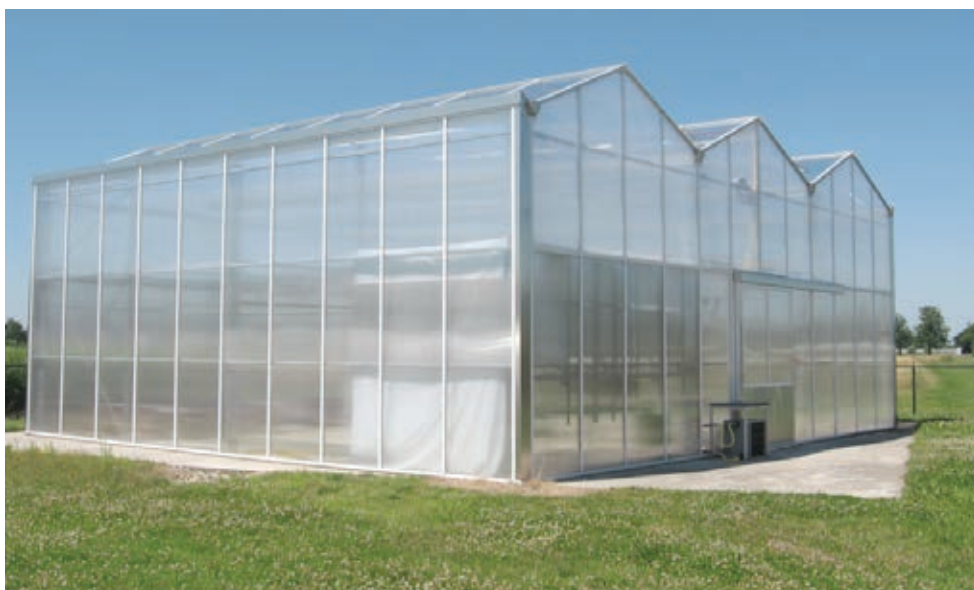
Figuur 36. Foto van de Elkas II. De kas is gebaseerd op een standaard Venlo kastype.
