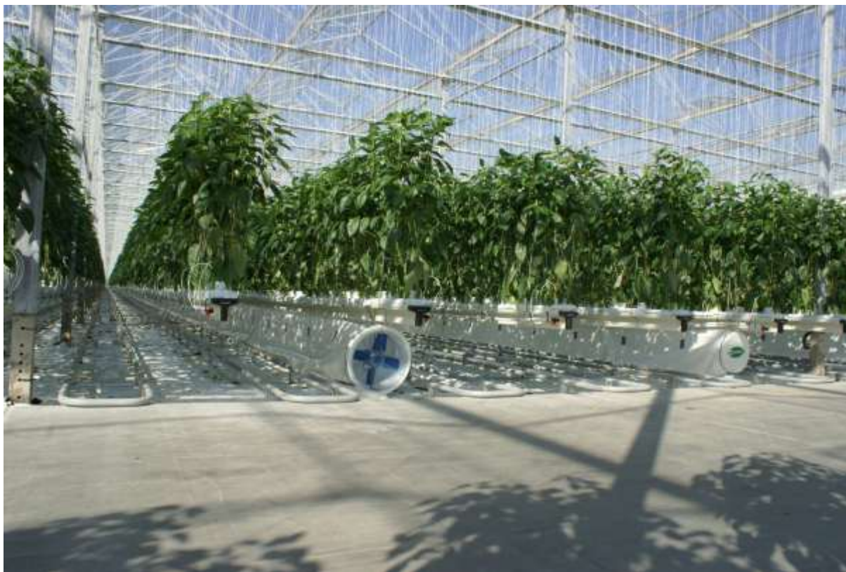
Figuur 1a: Gubbels Siberië Het Nieuwe Telen kas, nieuwbouw 2010. Per 8 meter kap 1 slurf om kaslucht te recirculeren en 1 slurf om buitenlucht in te blazen (foto: Peter Geelen)
