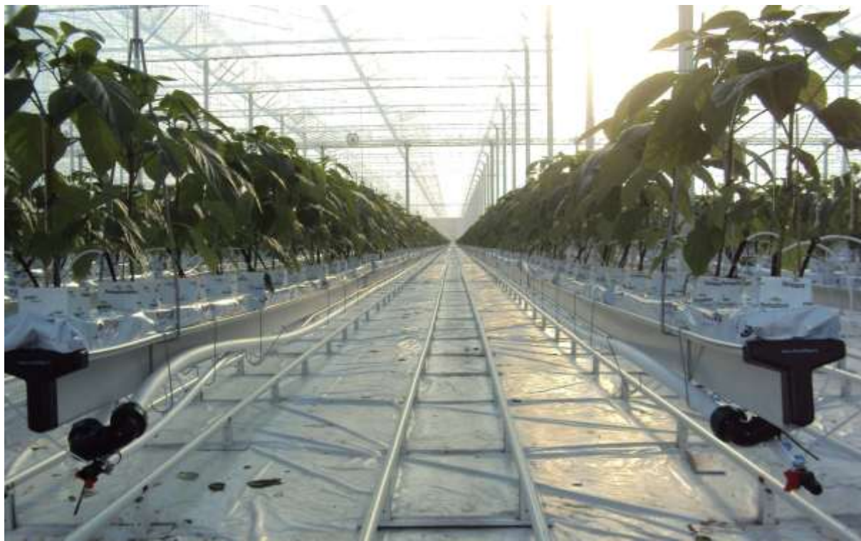
Figuur 1b: Gubbels Siberië Het Nieuwe Telen kas, nieuwbouw 2012, met LT net onder de goten. Slurven zijn niet zichtbaar, maar bevinden zich buiten de foto. (foto: Pascal Janzen)
