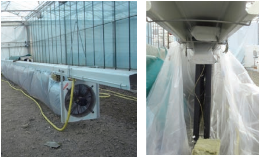
Figuur 5.1. FCA prototype 3 met folie-omhulling en 12m lengte.
