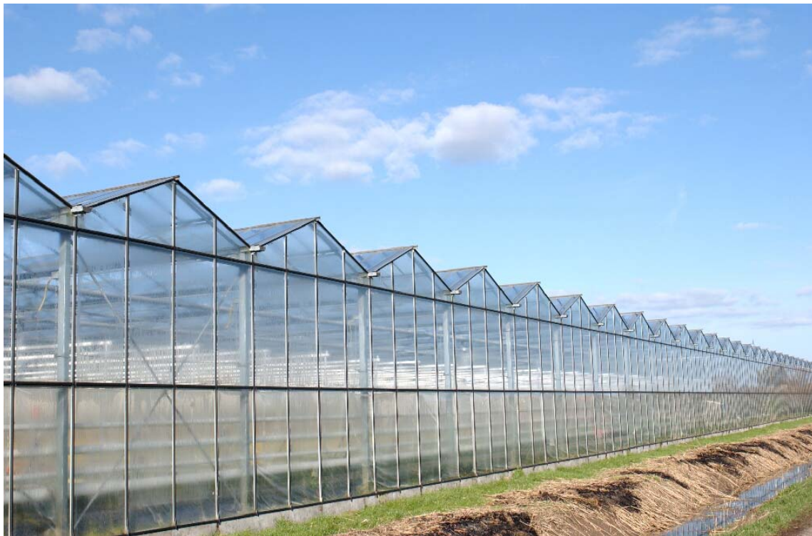
Figuur 4 Foto van een Venlo-kas met gevelverwarming
