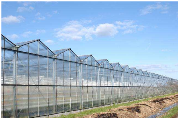
Een kas van het Venlo-type gebruikt in de glastuinbouw
