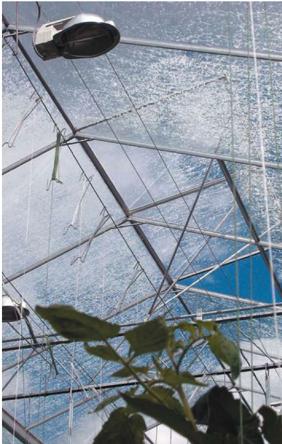
Een selectief krijt dat voornamelijk het NIR-deel van het lichtspectrum weet te weren, is al een aanzienlijke verbetering.
