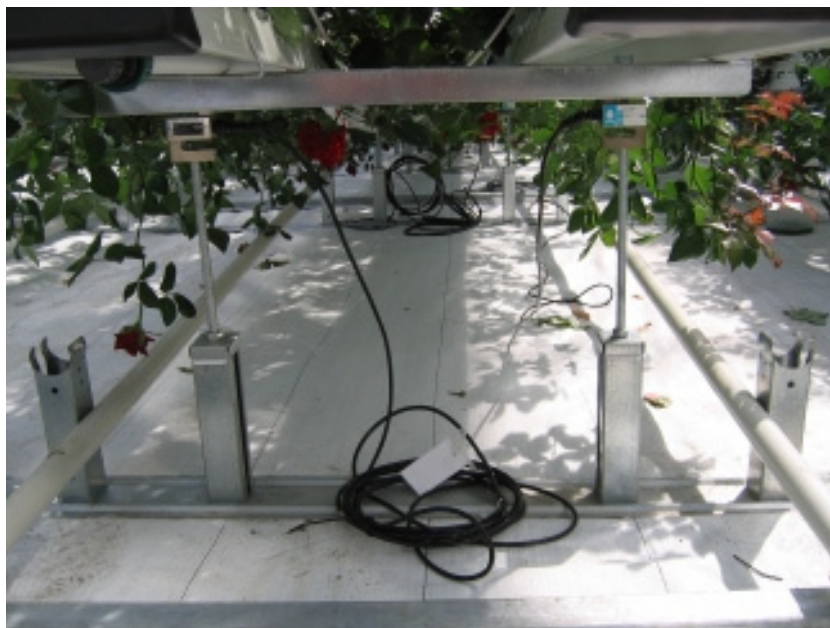
Figuur 2. Detail van de twee stalen goten geplaatst op loadcells.
