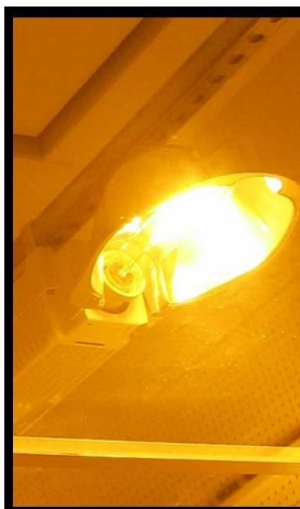
SON-T lamp (links) en de combinatie van rode en blauwe LED lampen in de klimaatkamer (rechts).
