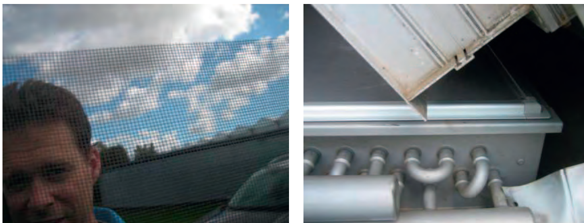
Figuur 2.11. Gaasfilter (links) opgelegd op het verwarmingsblok (rechts).
