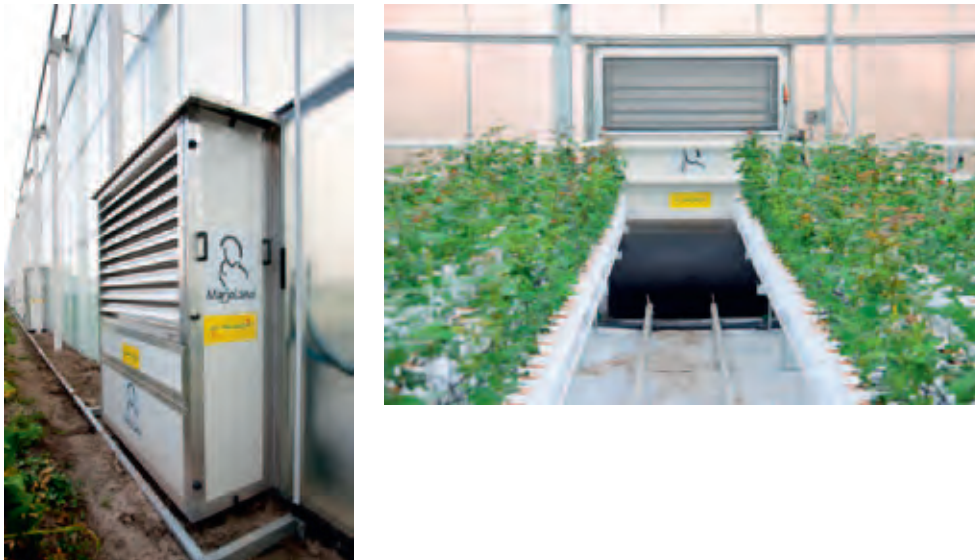
Figuur 2.1. LB kast en het luchtverdeelsysteem.
