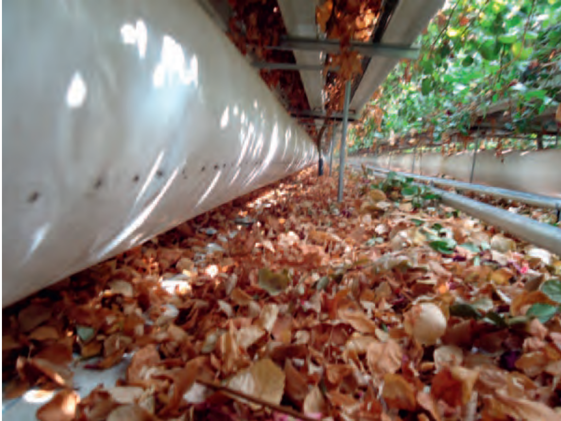
Figuur 2.7. Perforaties in de inblaasslangen.
